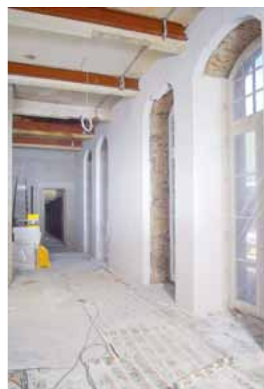
Multipor – ocieplenie od wewnątrz ścian oraz ościeży
